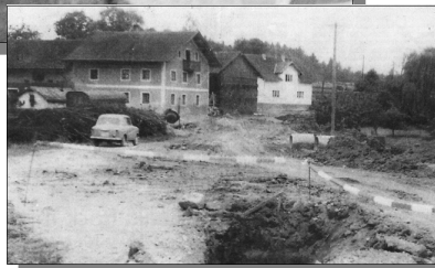
Aufnahme der Straßenbauarbeiten zur Kreisstraße CHA 50 im Jahre 1961/ 62
