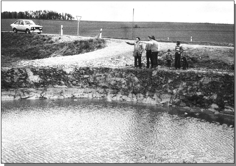
Der neu errichtete Löschweiher in Kothrettenbach
